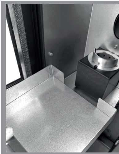
Abb. 5a: Reinigung des Aschekastens
